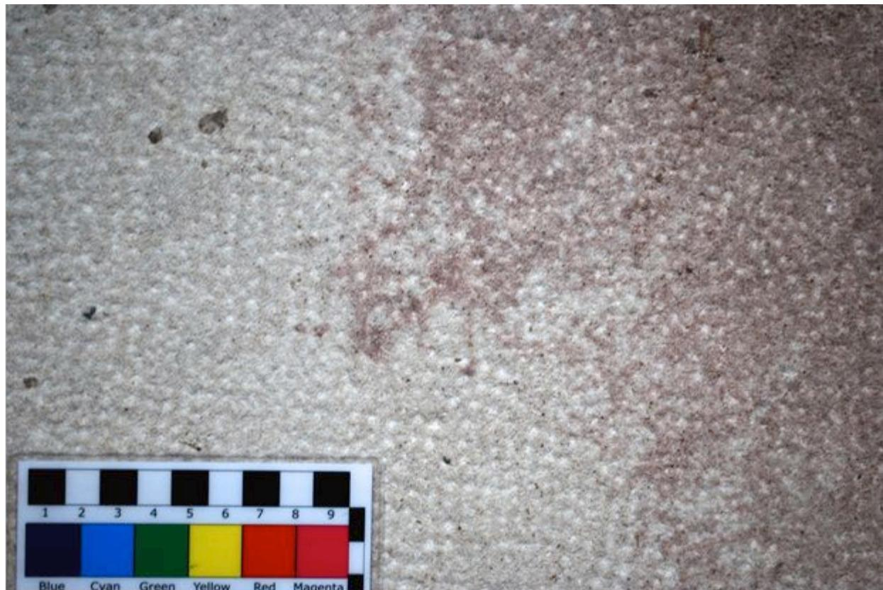
Abbildung 2.1: Oberfläche eines Degerfelder-Quaders mit gestockter Textur.
