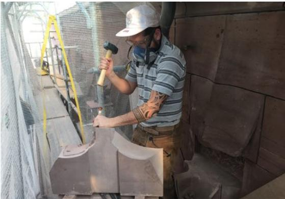
An einem der Pfeiler zum Innenhof musste an der Verdachung eine grosse Vierung eingesetzt werden. Dieses grösste in dieser Etappe zu ersetzende Stück wurde durch unseren Steinbauer Jérôme Lorenz auf dem Gerüst vorkonfektioniert, eingepasst und in Situ fertig gehauen. Abschliessend wurde die Oberfläche mit der Zahnfläche bearbeitet und so der gestockten Oberfläche der anschliessenden Partien angepasst.
