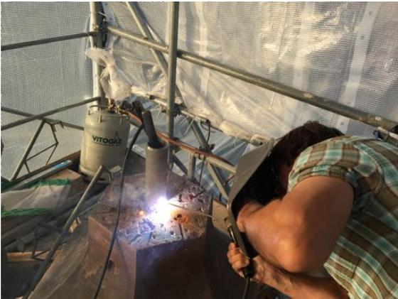
Der im bestehenden Werkstück noch fest verbleite Rundstahl wurde innerhalb des neuen Schaftestückes durch ein vor Ort angeschweisstes Rohr gekoppelt.
