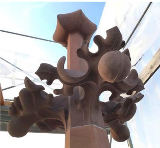
31.08.2016, 16:57 Uhr: Das Werk ist vollbracht, die Kreuzblume steht wieder fertig verbleit auf dem Giebel des neuen Giebelabschlussstücks am Nordquerhaus.
