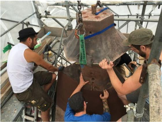
Nachdem das neue Giebelabschlussstück versetzt worden war, musste der untere Schafteil zusammen mit dem Kranzstück passgenau aufgesetzt werden.
